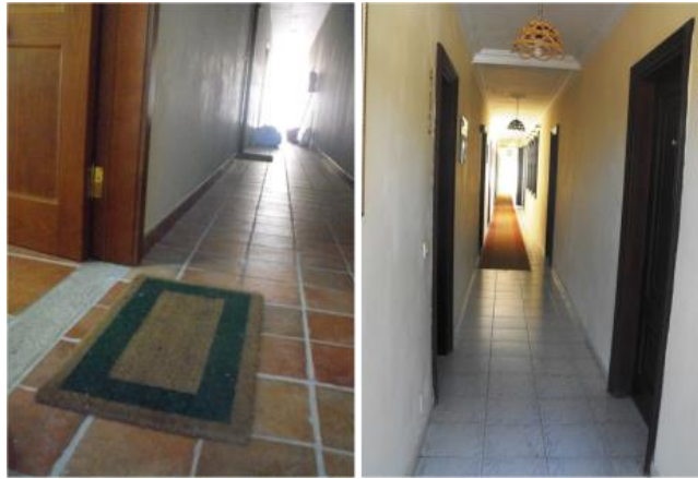
Foto 62: Pasillos internos del complejo Los Talares
