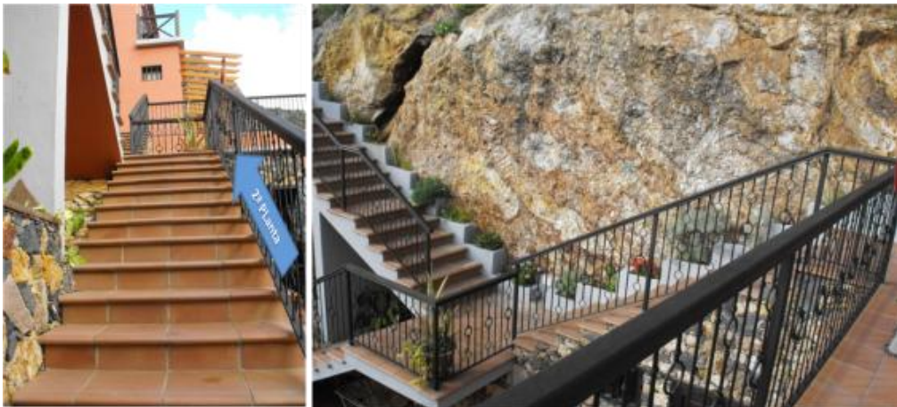
Figura 10: Escaleras de acceso al edificio superior del Hotel Rural Tamahuche
