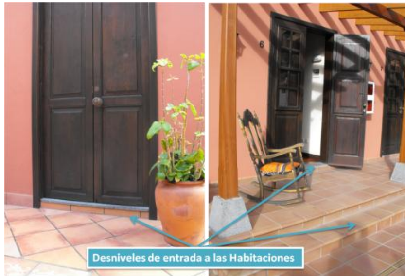
Figura 11: Accesos de entrada a las habitaciones del Hotel Rural Tamahuche
