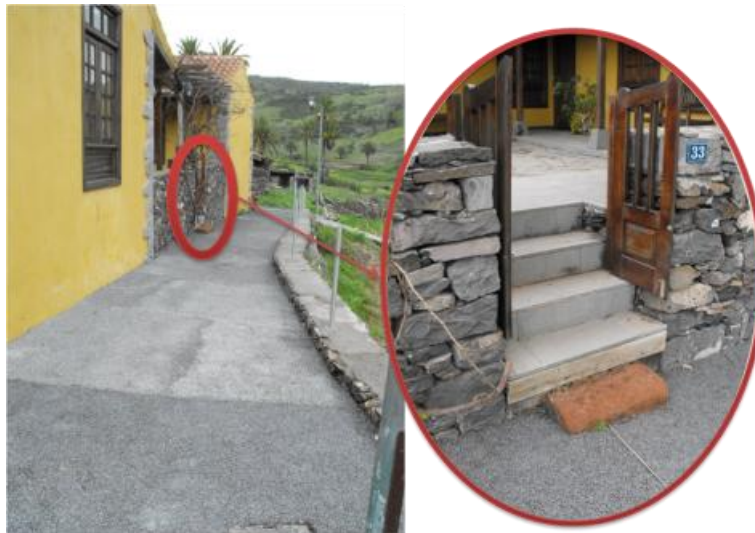
Foto 18: Acceso de entrada a la Casa Rural La Vega
