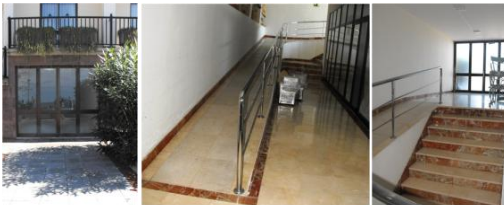
Foto 63: Detalles de la entrada alternativa del Hotel Gran Rey, adaptada para PMR
