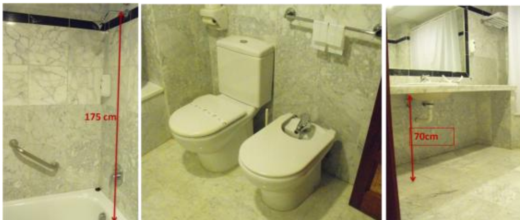
Foto 40: Detalles del baño de la habitación en el hotel Torre del Conde
