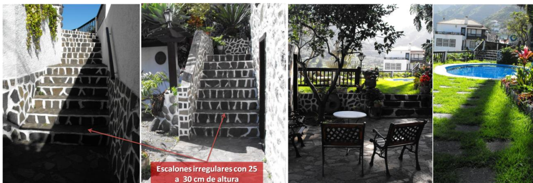
Foto 58: Recorrido de acceso a la zona de la piscina del complejo Los Talares
