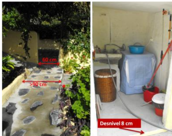
Foto 75: Detalles del acceso a la zona de lavadora de la casa La Vecindad
