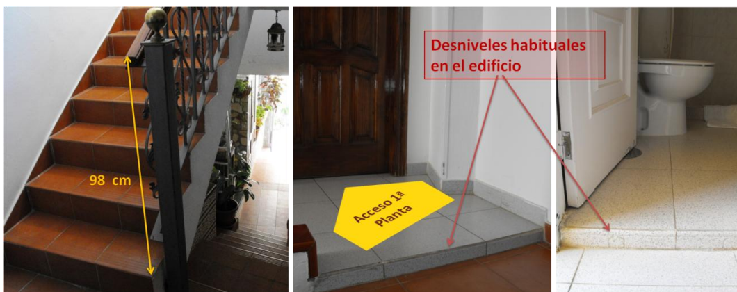
Foto 49: Accesos en el interior de la pensión Candelaria (izquierda) y ejemplos de los desniveles de acceso existentes en el interior de la misma
