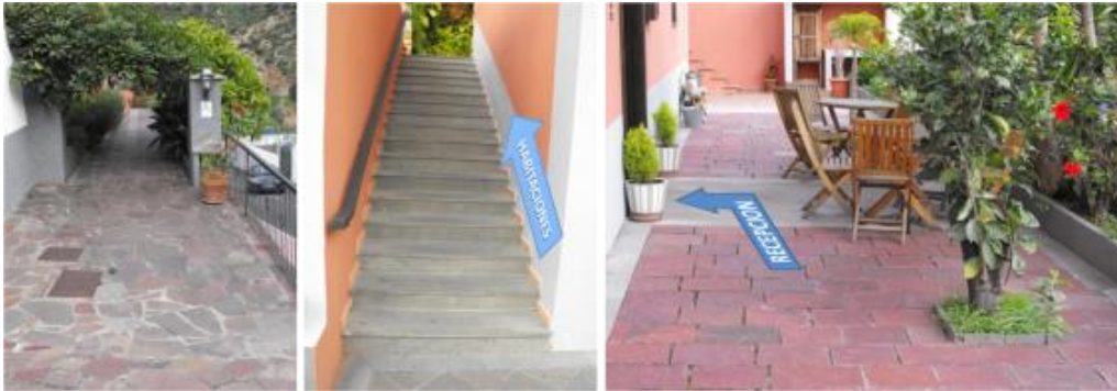
Foto 9: Detalles de la zona de entrada al edificio del Hotel Rural Tamahuche
