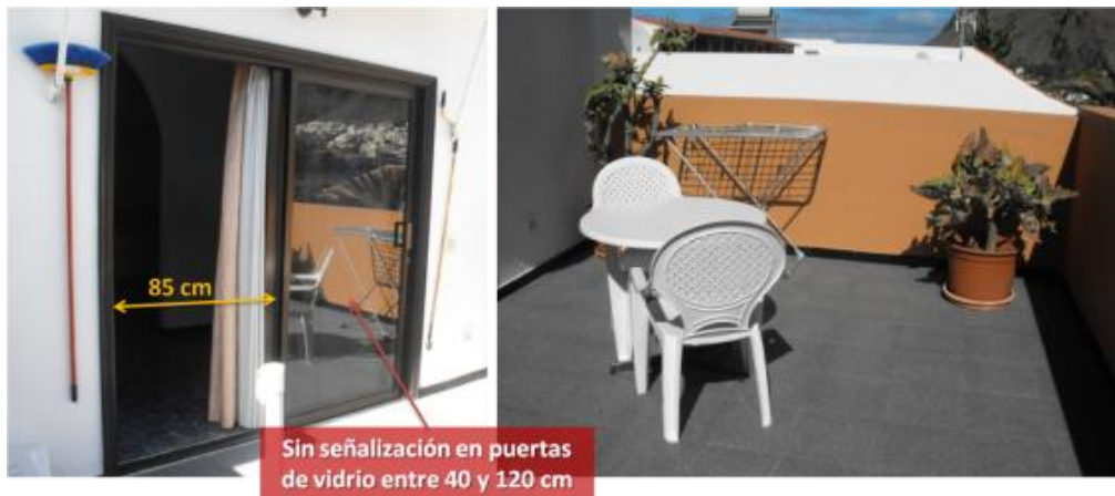
Foto 85: Detalles de la terraza del apartamento Sonsafé
